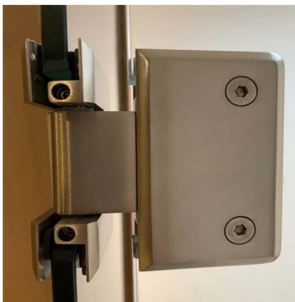
**Hinweis:** KNACKENDE SCHARNIERE - ein knackendes Geräusch wird durch den Stift innerhalb der Scharnierachse verursacht, der beim Öffnen der Tür einrastet. Dies lässt sich leicht beheben, indem diese beiden Sechskantschrauben mit einem 2,5-mm-Inbusschlüssel angezogen werden.
